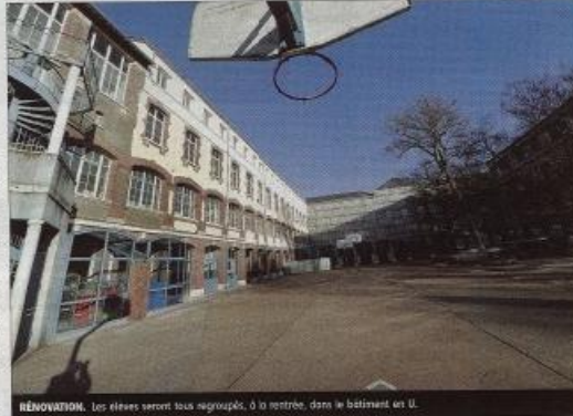
RÉNOVATION. Les élèves seront tous regroupés, à la rentrée, dans le bâtiment en U.
